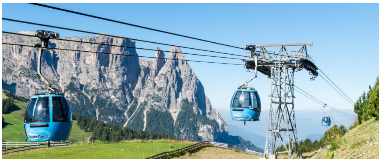
Figura 19 - Esempio di impianto bifune tipo 2S dotato di cabine in grado di ospitare fino a 16 persone.
