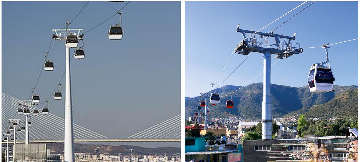
Figura 14. Esempio di sostegni e rulliere tipo.
