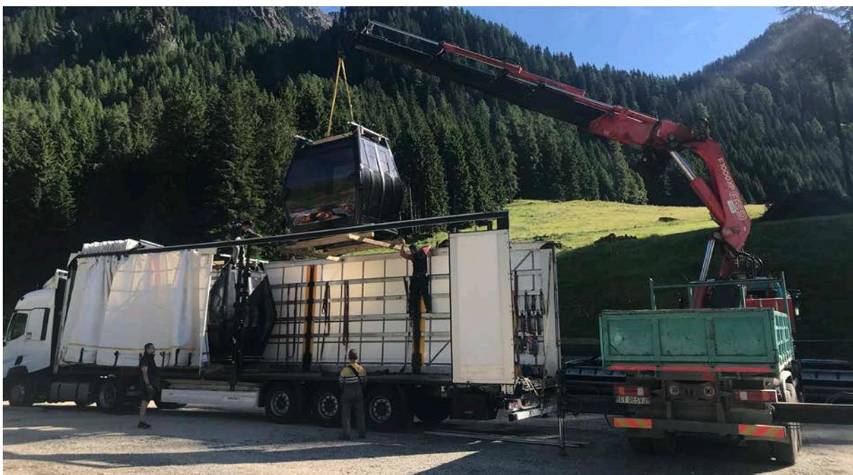
Foto 7. Scarico delle cabine decaposto da un bilico al loro arrivo in cantiere.
