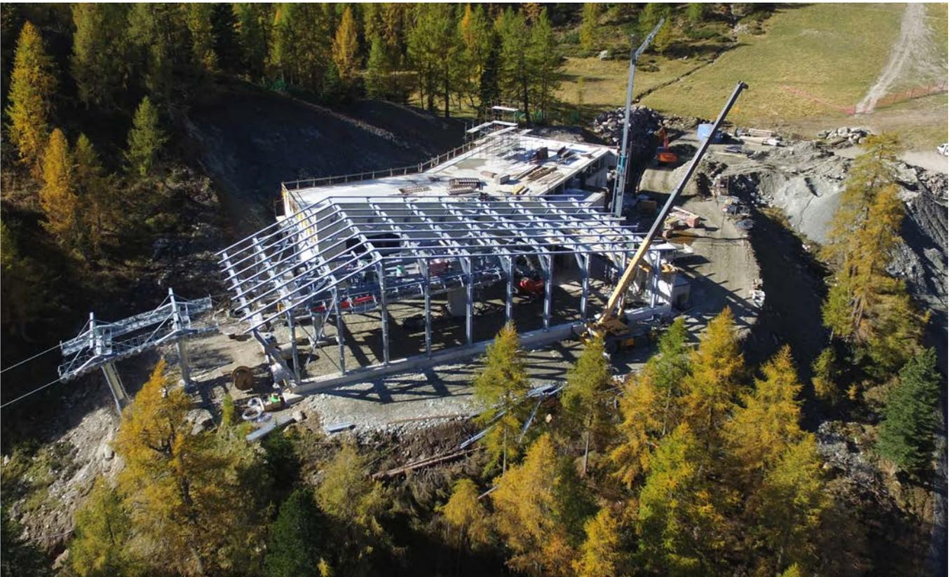
Foto 9 e 10. Montaggio delle strutture portanti in acciaio delle coperture dei volumi edili che contengono le stazioni funiviarie realizzato dopo il montaggio delle componenti funiviarie.
