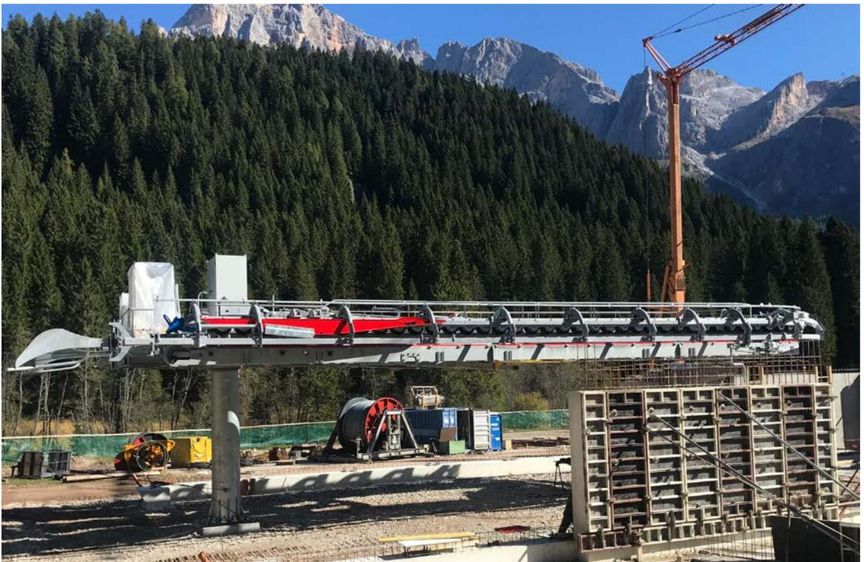
Foto 8 e 9. Montaggio delle componenti meccaniche di stazione prima della realizzazione del volume edile che le contiene.
