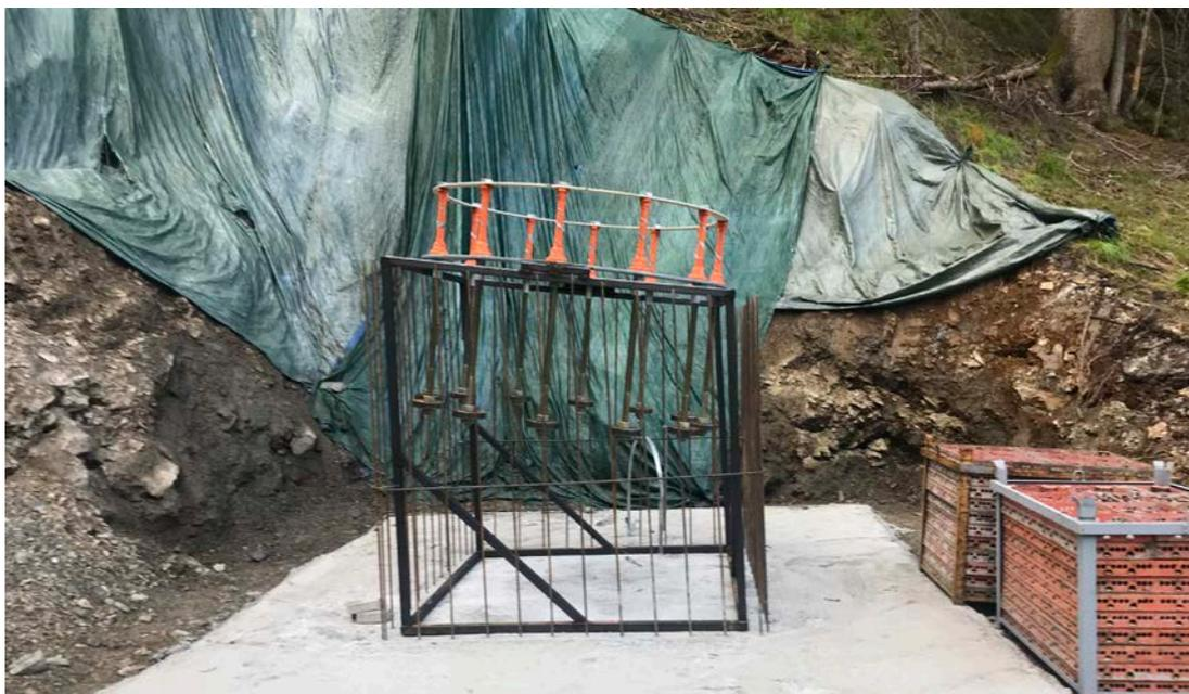
Foto 5. Predisposizione maschera di ancoraggio fusto prima del getto di una fondazione di linea di una cabinovia (prima della posa dei ferri di armatura del dado in elevazione).
