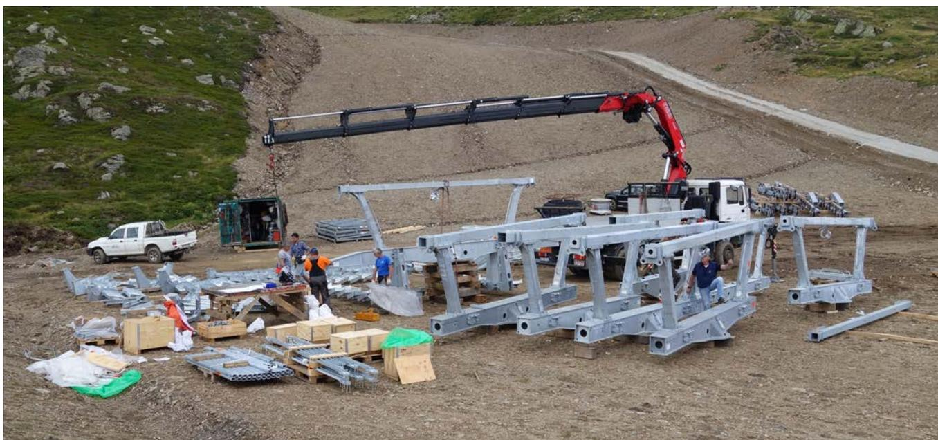
Foto 11. Pre-montaggio delle componenti di linea di un impianto a fune.
