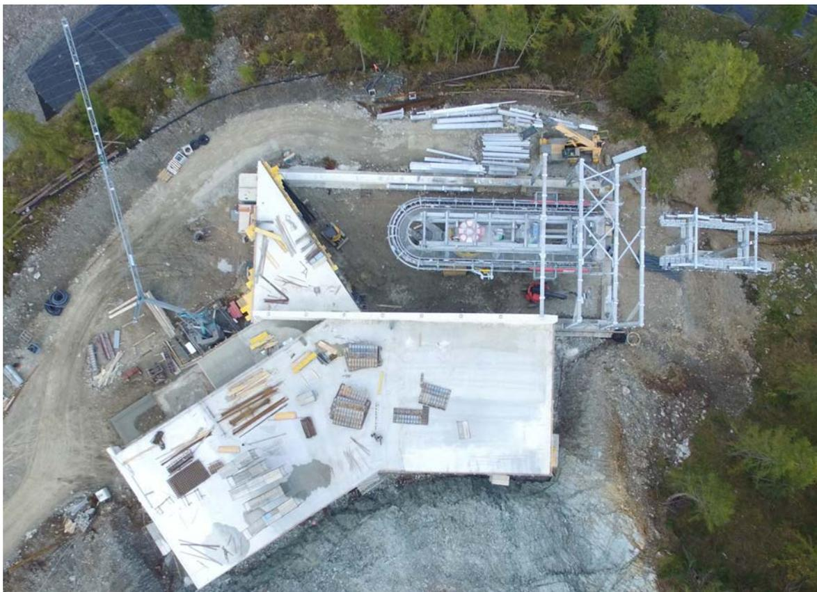
Foto 3. Area di cantiere di una stazione motrice di cabinovia con magazzino veicoli.
