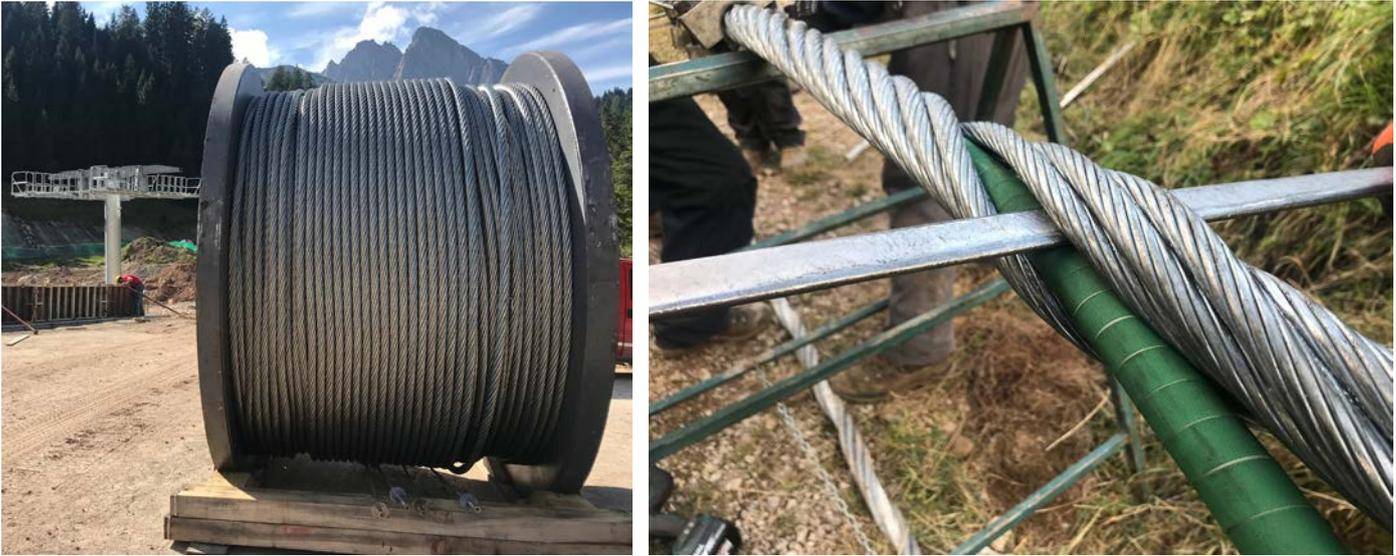
Foto 13 e 14. A sinistra: bobina di fune portante traente di una cabinovia pronta per essere svolta lungo la linea. A destra: particolare operazioni di impalmatura della fune.
